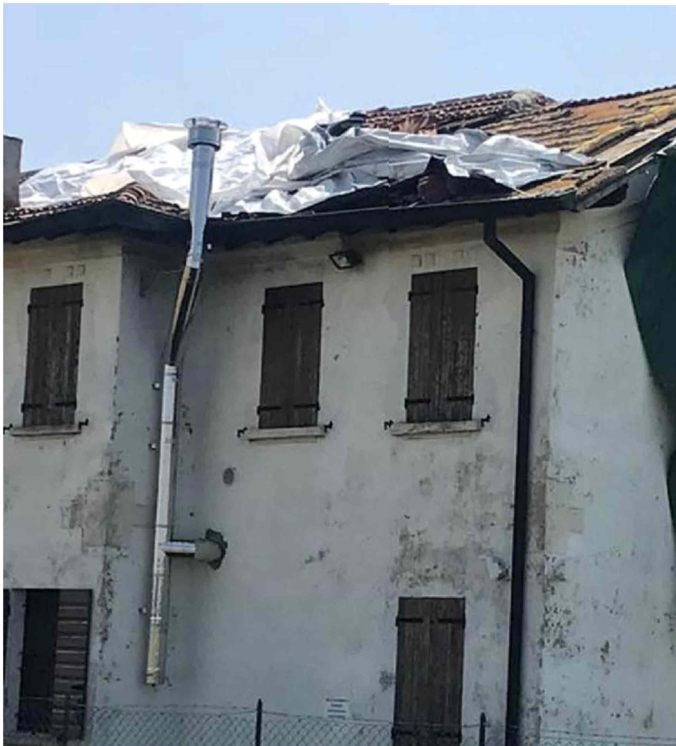
L'abitazione di Sorgà, ora inagibile, alla quale il tifone ha fatto volare buona parte del tetto DIENNE FOTO
