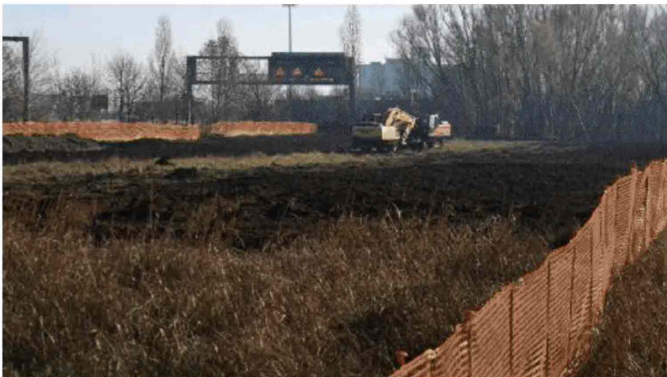
Area interessata ai lavori per il tracciato Tav
