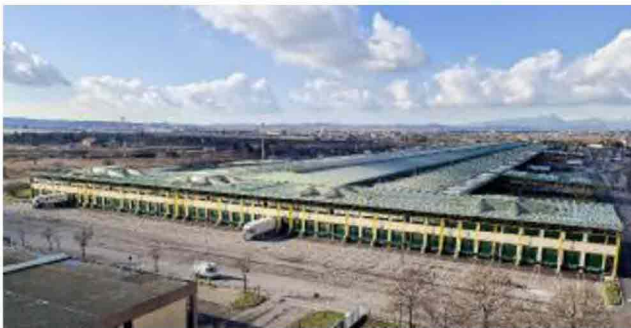
Veronamercato Una veduta aerea delle strutture
