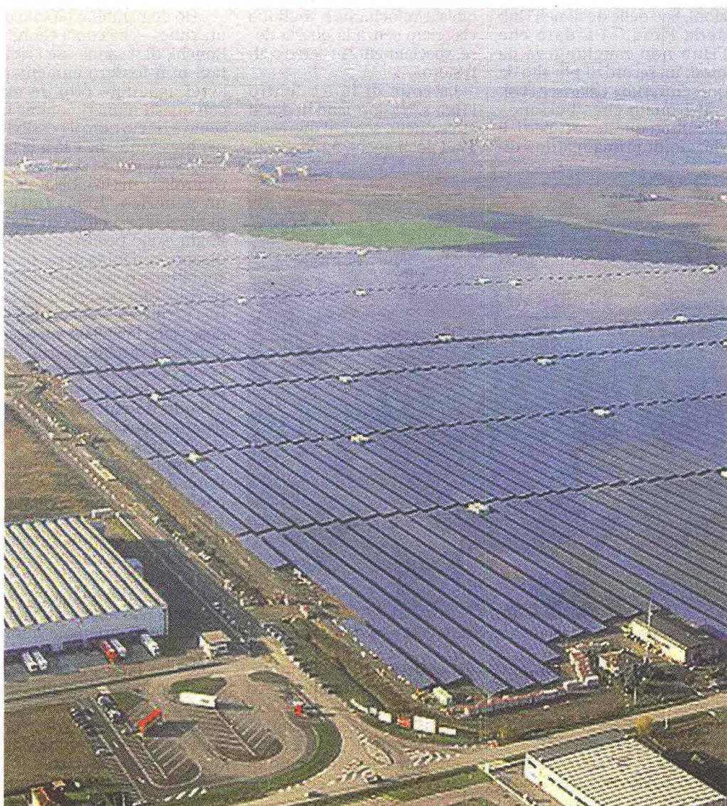
Il maxi impianto A San Bellino, a Rovigo, c'è uno degli impianti più grandi d'Europa: conta 280 mila pannelli
