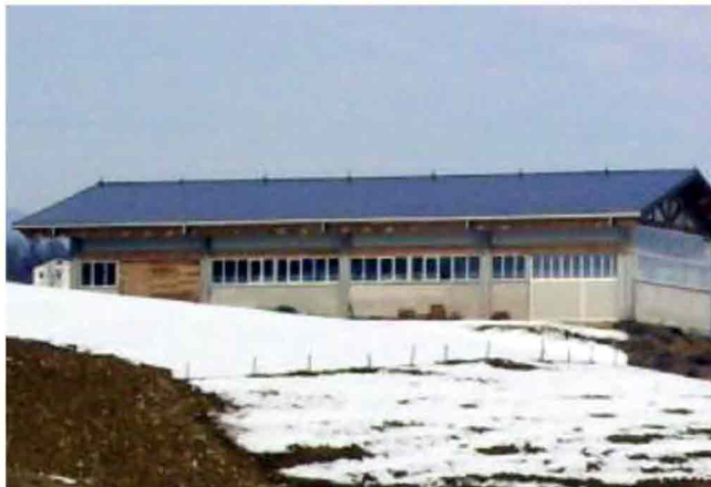
Un impianto fotovoltaico installato in una stalla
